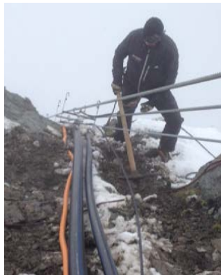
Auch bei widrigsten Umständen wird gearbeitet
